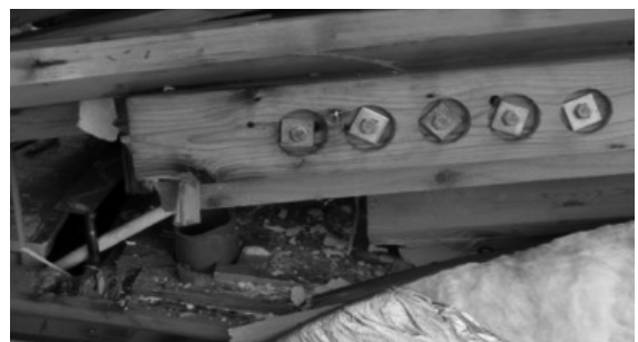
写真4 写真3の建物の写真 筋かい端部、柱脚接合部
