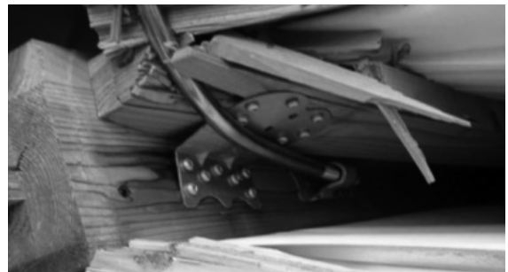
写真2 写真1の建物の写真 筋かい端部、柱脚接合部
